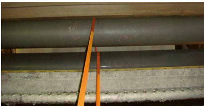
Foto 2: Wichtig – das Gurtband darf an keiner Stelle verdreht sein!
